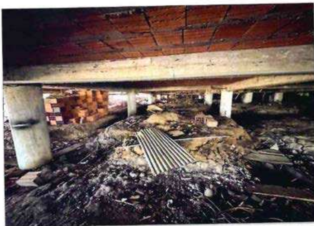
Imagen 08. Se puede observar el almacenamiento de ladrillos y desmonte producto de la ejecución de obra de la biblioteca.
