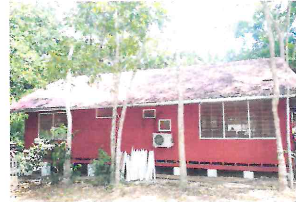
Fotografía 6. El ambiente requiere de mantenimiento y cambio de equipos
